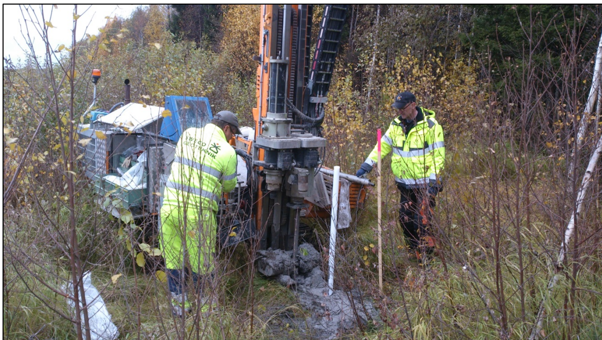
Figur 6. Installation av två separata grundvattenrör i provpunkterna GV-15-0005 (övre jordakvifer) och GV-15-0006 (undre jordakvifer).
